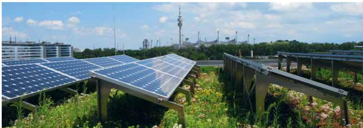
ABBILDUNG 3.2 – 6 ▶ Photovoltaik-Aufdachanlage mit Dachbegrünung, Münchner Technologie Zentrum.
